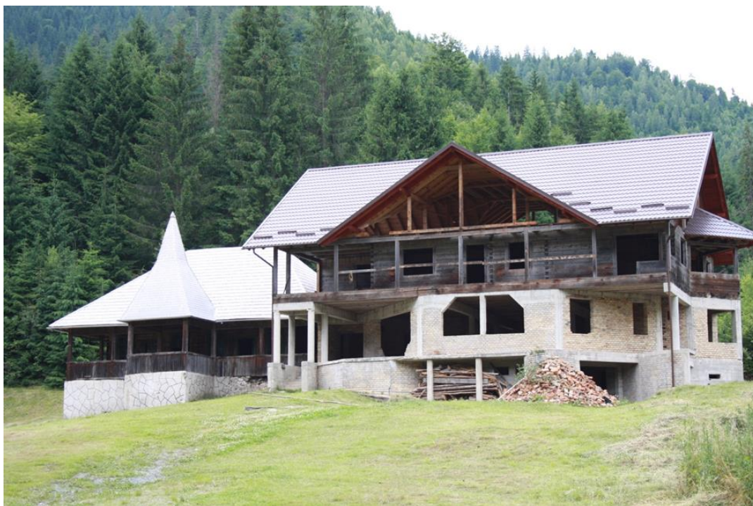
Fig 26 Casa de vânătoare Șoimu, clădirea veche -stânga și clădirea nouă -dreapta
